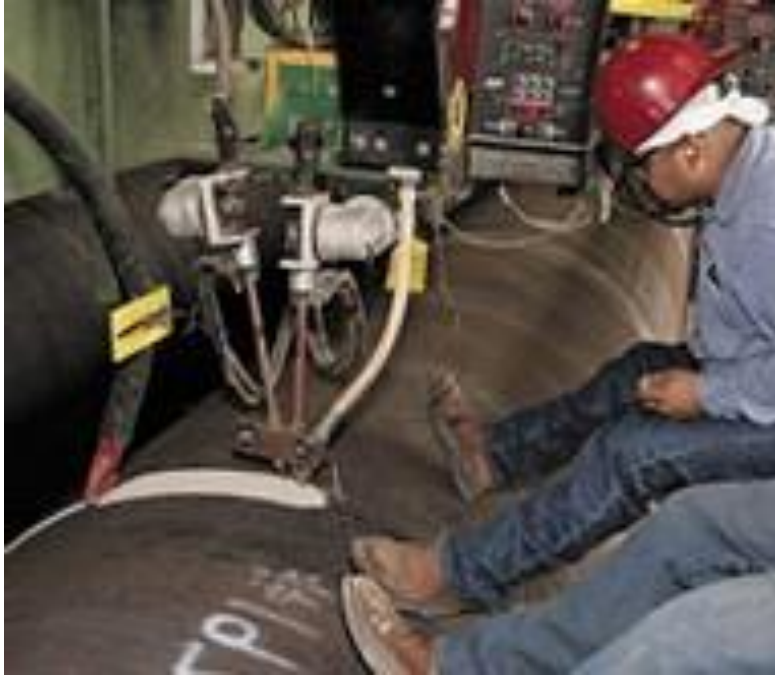
ओशन प्लेटफॉर्म का समर्थन करने के लिए लंबी स्टील के ढेर बनाने के लिए एसएडब्लू वेल्डिंग प्रक्रिया।
