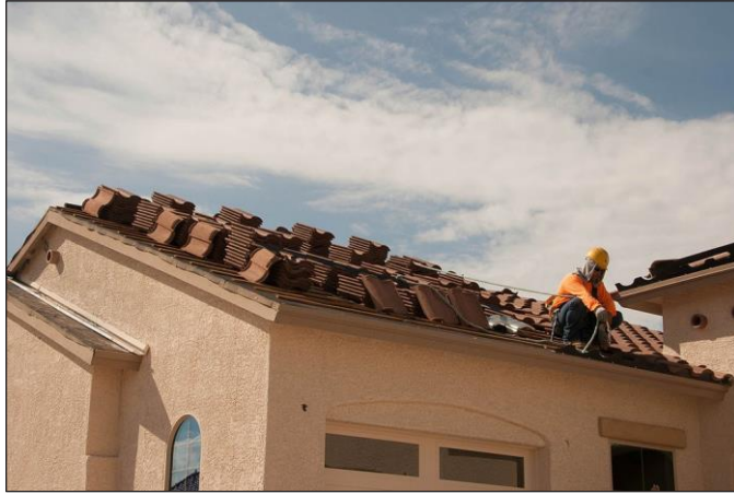
फीनिक्स, एरिजोना में एक घर की छत का निर्माण करने वाला श्रमिक।
