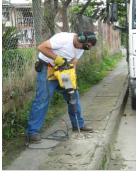
एक जैकहैमर का उपयोग करते समय कान और आंखों की सुरक्षा पहने हुए व्यक्ति।
