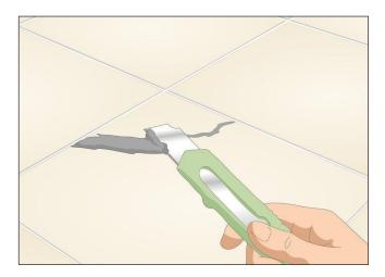
6. दरार के आसपास से अतिरिक्त सूखी एपॉक्सी को काट लें। टाइल पर मिलने वाले किसी अतिरिक्त एपॉक्सी को दूर करने के लिए रेजर ब्लेड के तेज किनारे का उपयोग करें। एपॉक्सी को साफ करने के लिए, ब्लेड को टाइल की सतह के खिलाफ 45 डिग्री के कोण पर रखें। इसे हटाने के लिए अतिरिक्त एपॉक्सी के नीचे स्लाइड करें।
