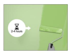
5. अतिरिक्त कोट लागू करें। नया रंग आप कितना गहरा चाहते हैं, इस पर निर्भर करते हुए, आप पेंट के दूसरे या तीसरे कोट को रोल कर सकते हैं। दीवार के बाहरी किनारों के साथ शुरू करने और अपने तरीके से आवक काम करने के लिए, इन अनुवर्ती कोट को उसी तरह पेंट करें। कोट के बीच 2-4 घंटे इंतजार करना सुनिश्चित करें ताकि ताजे पेंट को सूखने का समय मिल सके।
