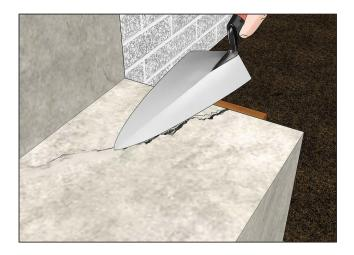
6. विनाइल कंक्रीट पैचर लगाने के लिए एक ट्रॉवेल का उपयोग करें। दरार के सबसे गहरे हिस्से में कुछ यौगिकों को काम करें, और इसे ट्रॉवेल के साथ दबाएं। उस परत पर तब तक निर्माण करें, जब तक आप दरार को ओवरिफल न कर दें। फिर अतिरिक्त यौगिक को हटाने के लिए ट्रॉवेल का उपयोग करें, सतह को चिकना करें, और बाकी सीढ़ियों के साथ कंपाउंड को समतल करें।
